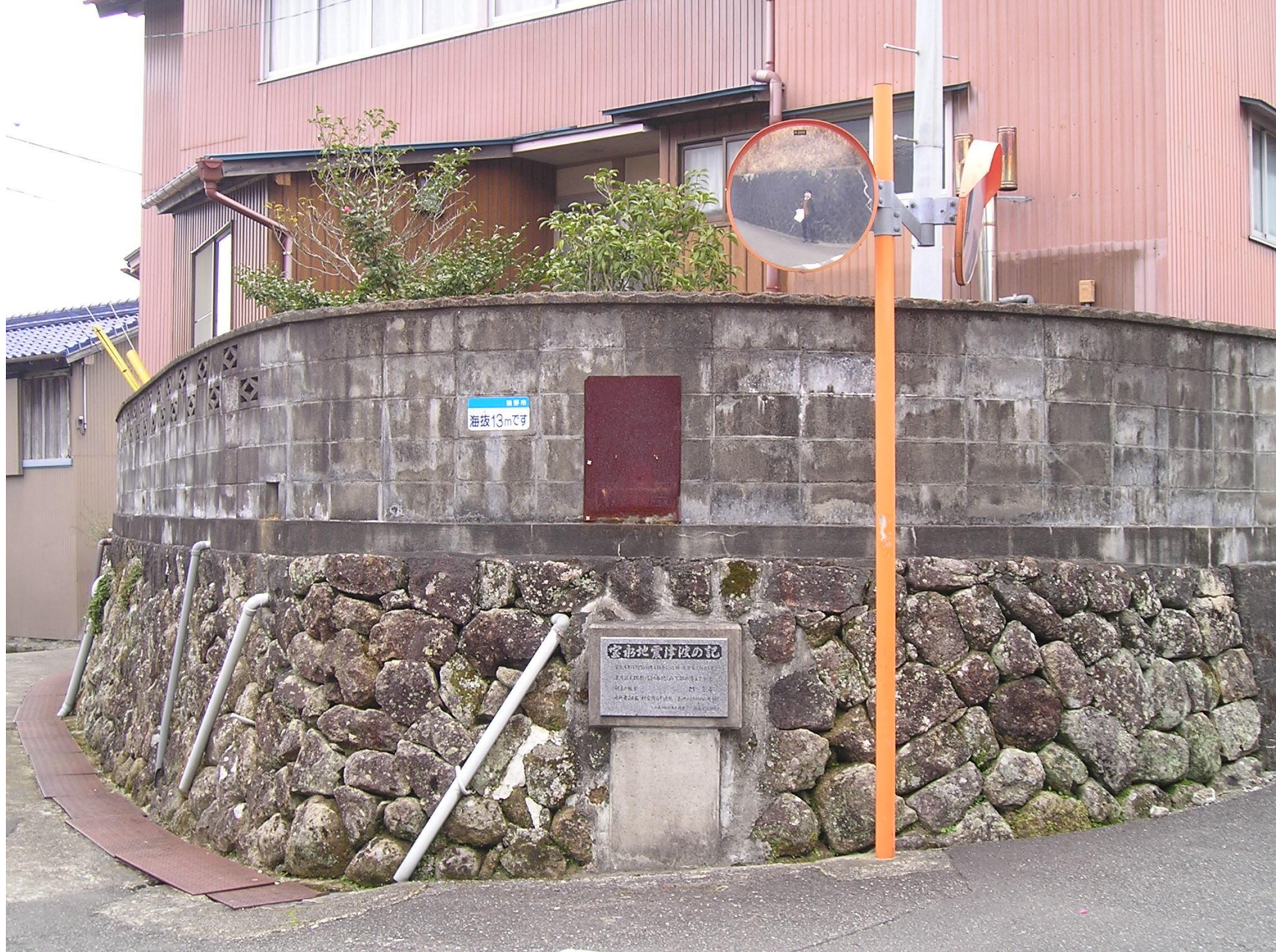
熊野市新鹿町JR新鹿駅北方の線路東側沿いの民家の石垣にある「宝永地震津波の記」の遠景。
