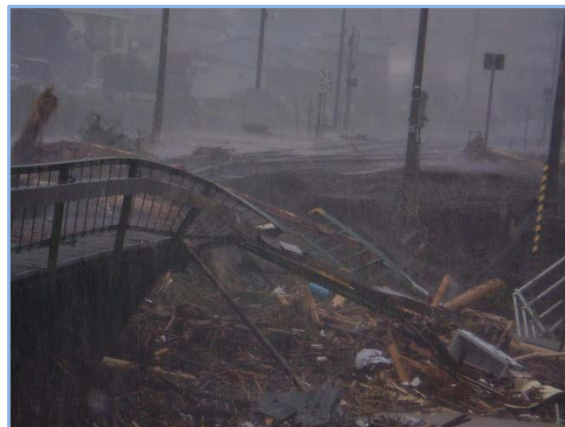
熊野市内における紀伊半島大水害による被害(井戸川 JR 河口付近)
